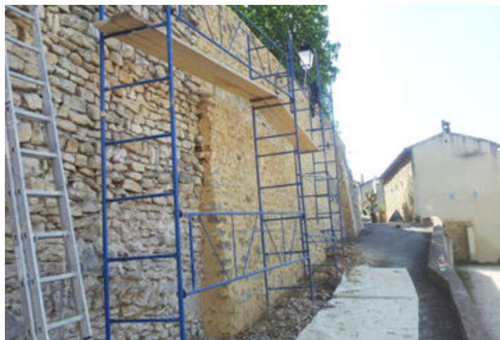
Renforcement du mur du Portalet. D'autres travaux ont été réalisés sur la commune, comme l'enfouissement des réseaux place du puits neuf, la création et le nettoyage des fossés... Et d'autres suivront pour entretenir et améliorer le patrimoine naturel et bâti de la commune, nous vous tiendrons informé de l'avancée de ses actions.
