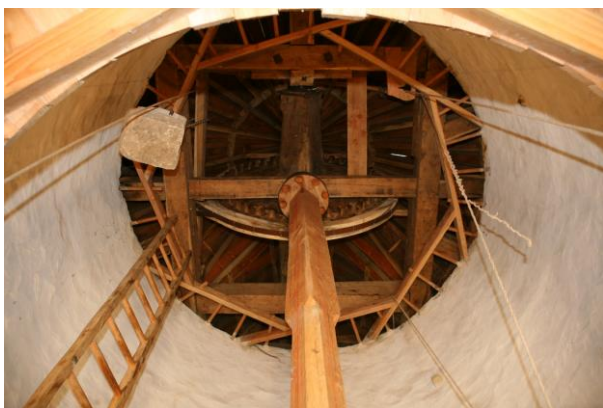
Charpente réalisée par Bernard Garibal spécialisé en Moulin à Vent
